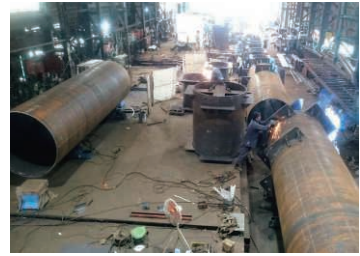
一般産業工事 (富士石油5号栈橋ジャケット用杭加工)
