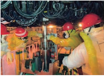
原子力発電所メンテナンス (制御棒点検)
