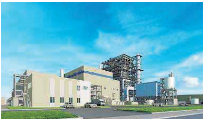
福島いわきバイオマス発電所 (112MW)
