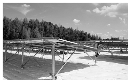
栃木 河内郡上三川町発電所 両面パネルへの入替え・反射シートの設置後
