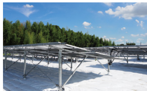
栃木 河内郡上三川町発電所 両面パネルへの入替え・反射シートの設置後
