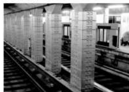
トンネル中柱補強
