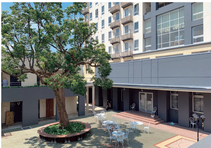
和歌山県海南市 シニア向けマンション （ウェルネス・コート海南）
