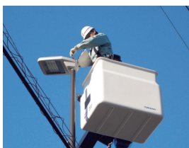
道路照明灯保守
