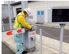
高速道路通信設備保守
