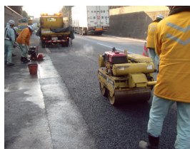
維持修繕工事
