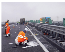
事故・災害復旧工事
