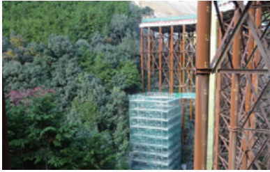
橋梁下部工事
