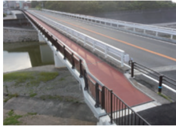
交通安全対策工事
