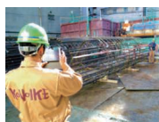
杭施工記録の様子
