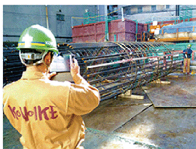
杭施工記録の様子
