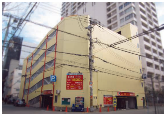
大阪市 立体駐車場（ヤマイチパーク京町堀）
