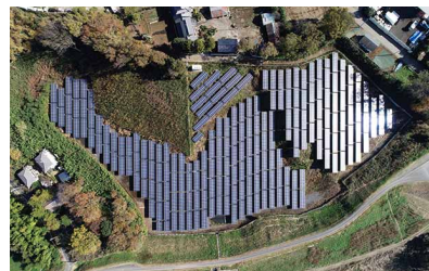
所在地：茨城県坂東市 パネル出力：1.1MW
