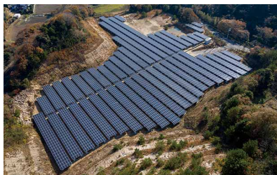
所在地：山口県山口市 パネル出力：1.5MW
