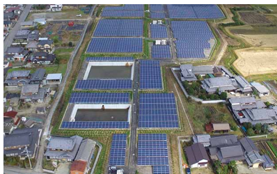
所在地：兵庫県多可郡 パネル出力：1.6MW
