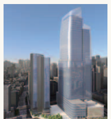
2017年4月 東京駅前 常盤橋 プロジェクト 着工
